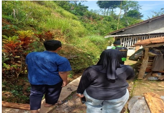
Foto 4. 12 Observasi Wilayah Longsor Dusun Pahing
