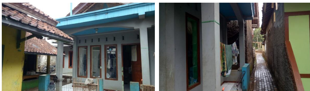
Gambar 3.2 Kondisi Perumahan Desa Sekarwangi
