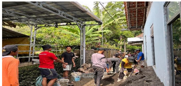
Foto 5. 3 Kerja bakti Cimentut
